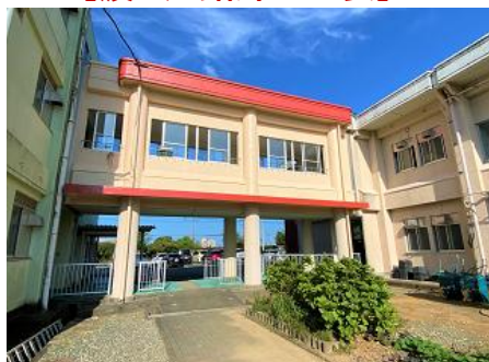
【渡り通路外壁塗装】
